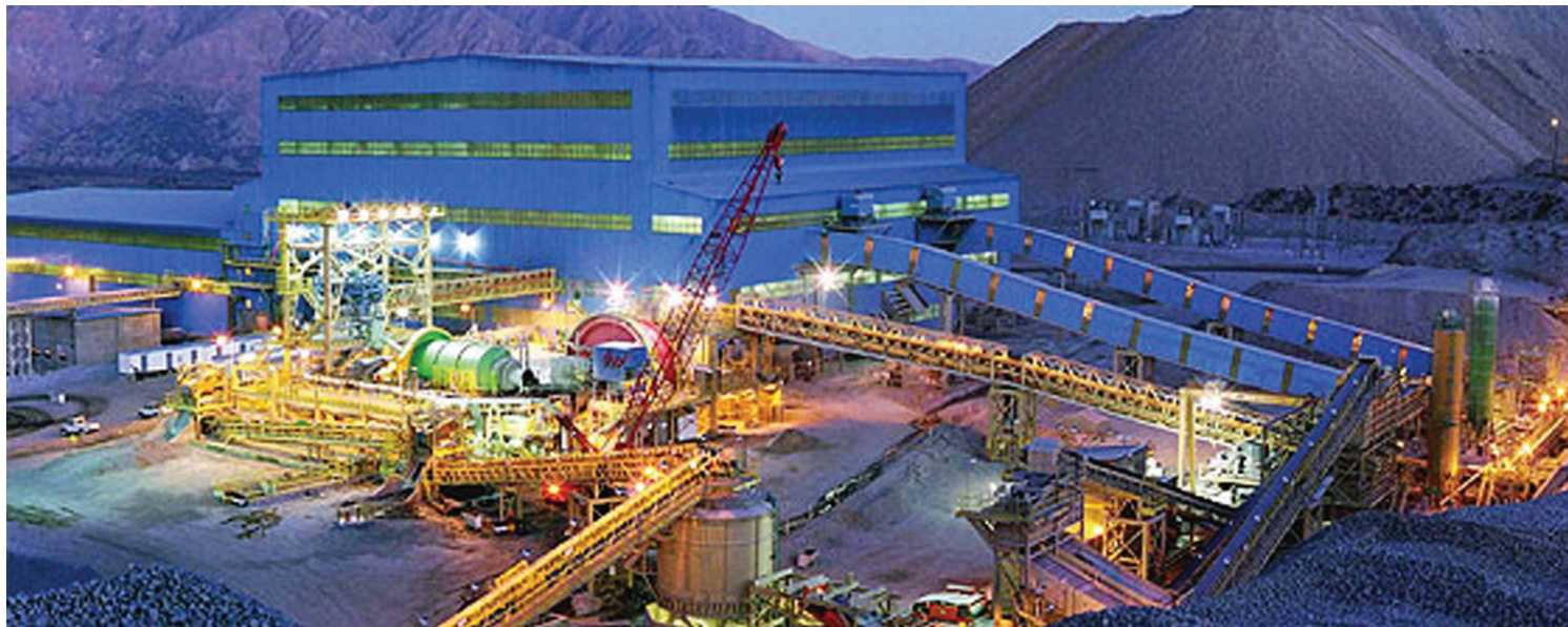
Imagen 3. Fuente: http://www.alumbrera.com.ar/art-009-a.asp . Planta de Concentrado del Mineral de Minera Alumbrera Ltd. en la provincia de Catamarca.
